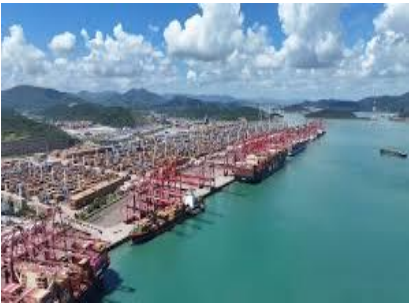
مرفأ Ningbo Zhoushan الصيني
